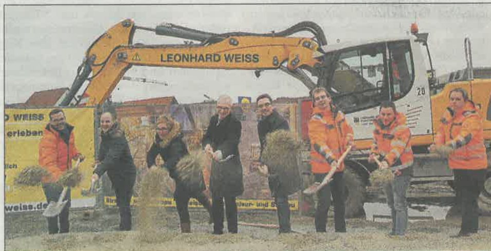
Und los geht's: Mit vollem Einsatz läuteten gestern Vertreter aller am Bau Beteiligten mit dem Spatenstich den offiziellen Baubeginn der Brücke ein.
