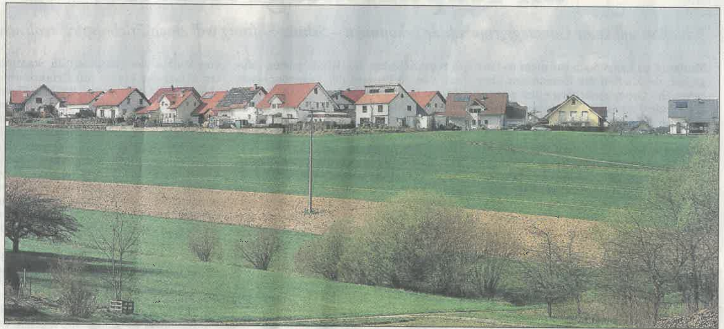
Der Vorentwurf zum Bebauungsplan „Steinigäcker/Gänsberg II“ in Seckach stand im Mittelpunkt der Einwohnerversammlung am Mittwoch in der Seckachtalhalle. Das Bild zeigt das neue Baugebiet, das von der Märzenquelle bis zu obigen Häusern reichen soll. Foto: Joachim Casel
