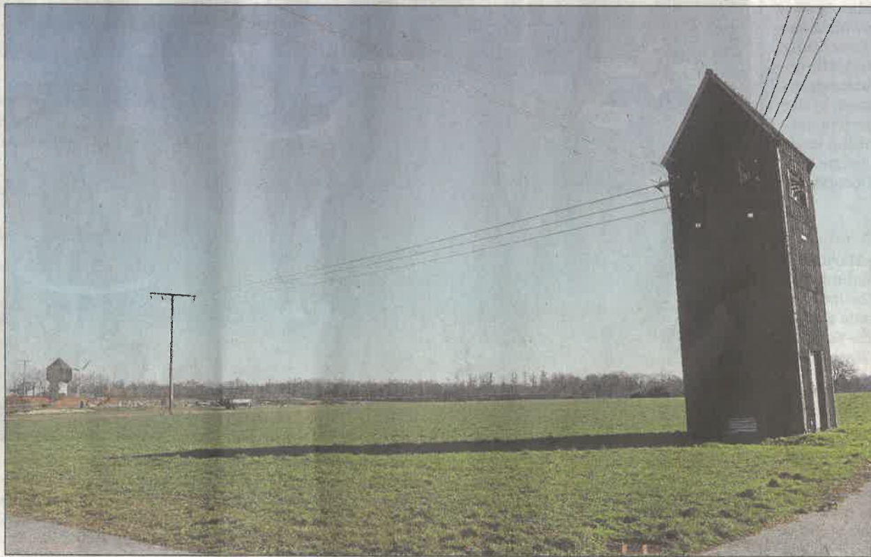
Im Baugebiet „Schindersacker“ im kleinsten Rosenberger Ortsteil Bronnacker soll ein attraktives Wohngebiet mit insgesamt acht neuen Bauplätzen entstehen. Der Gemeindeverwaltungsverband Osterburken nahm bei der letzten Sitzung jetzt auch Weichenstellungen in diesem Gebiet vor. Foto: Helmut Frodl
