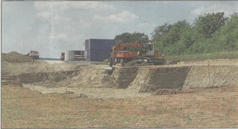
Die Erdarbeiten für das neue Seniorenheim sind bereits angelaufen. Foto: Rüdiger Busch
