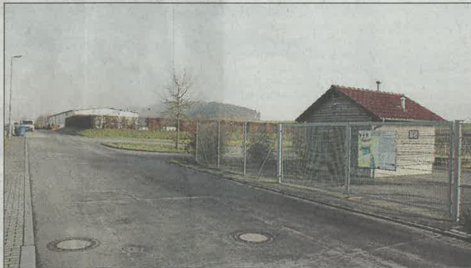
Gemäß eines mehr als 25 Jahre alten Vertrags muss die Stadt Walldürn die Straßen und abwasser-technischen Einrichtungen im Verbandsindustriepark – wie hier im Gebiet „Katzenwiesen“ – erwerben. Diese Übertragung ist inzwischen abgeschlossen. Foto: Adrian Brosch
