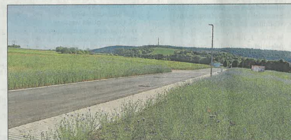
Das Hardheimer Baugebiet „Trieb II“ bietet ausreichend Platz für 85 neue Bauplätze. Derzeit ist nicht geplant, weitere große Wohnbauflächen in der Kerngemeinde auszuweisen.
