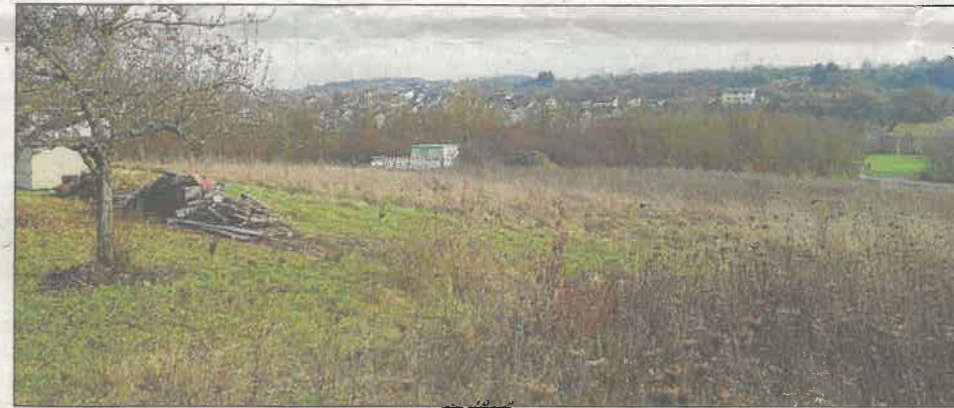
Blick auf ein Teilstück des Areals für das geplante Seniorenzentrum: Das Trafohäuschen (Hintergrund) wurde bereits errichtet. Foto: Rüdiger Busch
