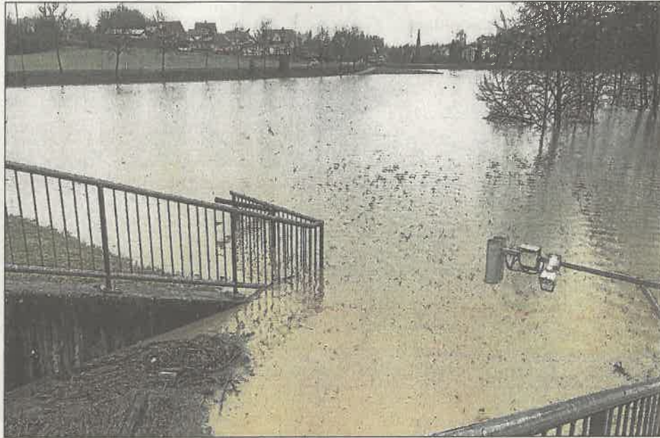
Vollgelaufen war das Rückhaltebecken in Mittelschefflenz nach den anhaltenden Niederschlägen zuvor zu Beginn des neuen Jahres. Foto: Gemeinde Schefflenz
