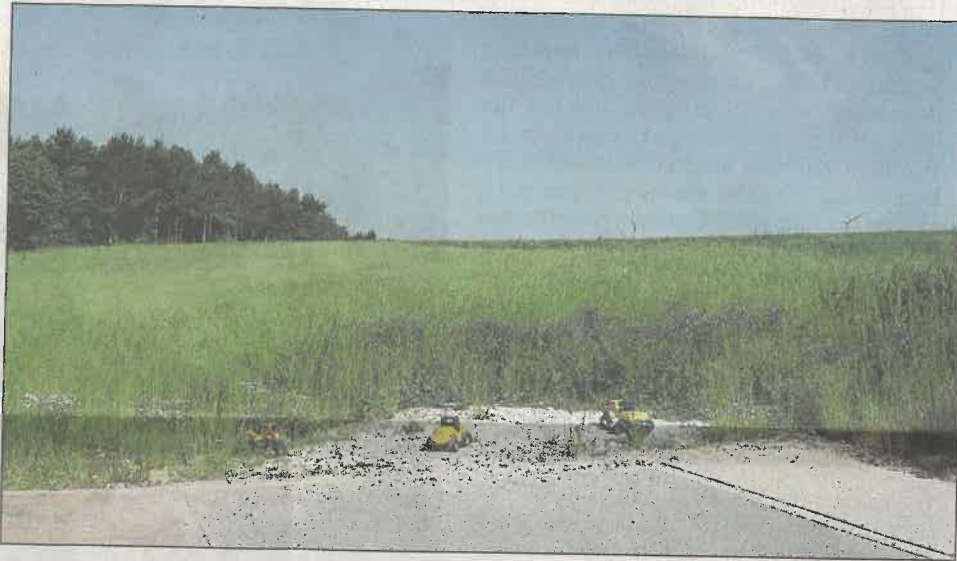
Im nächsten Jahr rollt hier statt der Spielzeugbagger großes Gerät an. Dann soll der dritte Bauabschnitt des Neubaugebiets „Matzenklinge“ erschlossen werden. Foto: Helmut Frodl
