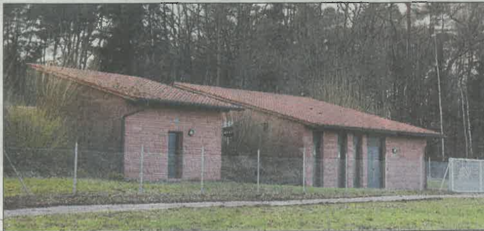
Erneuert wird die Förderleitung vom Wasserhochbehälter „Stallenbirken“ bis zum Gewerbegebiet „Stöckig“. Notwendig wurde die Maßnahme, weil es vermehrt zu Rohrbrüchen in der Förderleitung gekommen ist. Foto: L. Merkle
