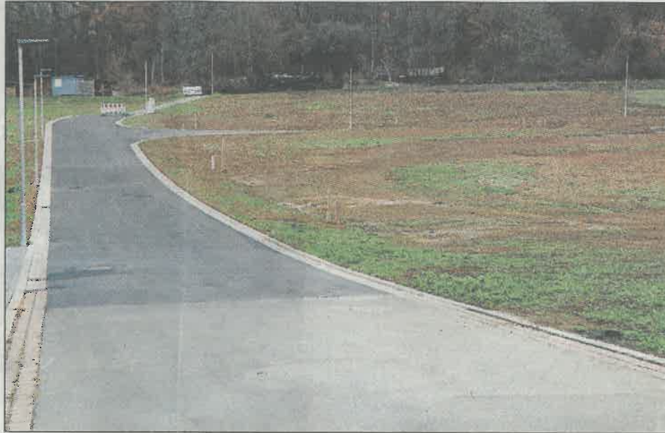
Für das neue Baugebiet „Adeldorn II“ in Sindolsheim wurden jetzt im Gemeinderat die Bauplatzpreise festgelegt. Foto: Helmut Frodl
